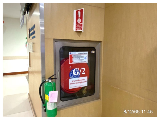
ถังดับเพลิง และตู้เก็บสายฉีดน้ำดับเพลิง พร้อมวิธีการใช้งานภายในอาคาร
