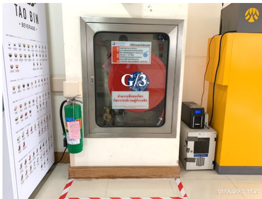
ถังดับเพลิง และตู้เก็บสายฉีดน้ำดับเพลิง พร้อมวิธีการใช้งานภายในอาคาร
