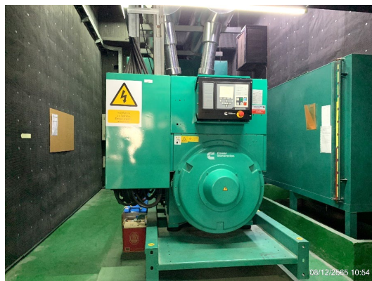
รูปที่ 2-16 เครื่องกำเนิดไฟฟ้าสำรอง
