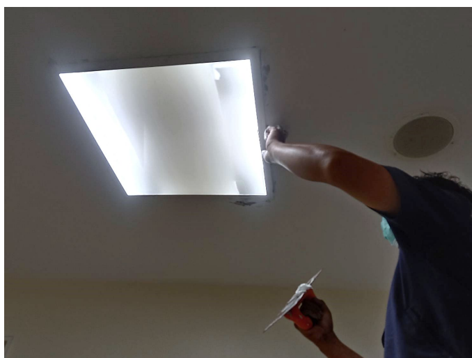
รูปที่ 2-15 งานเปลี่ยนโคมไฟและหลอดไฟที่ชำรุด
