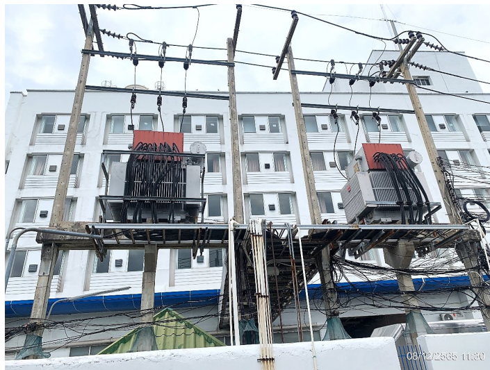
รูปที่ 2-14 หม้อแปลงไฟฟ้าของโครงการ
