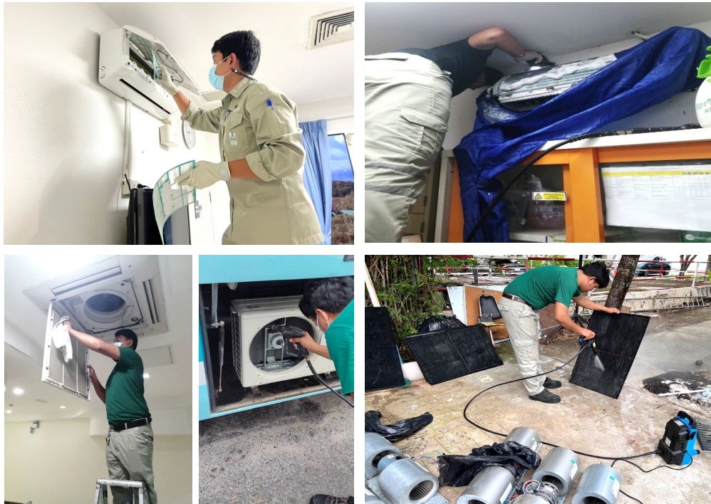
รูปที่ 2-7 เจ้าหน้าที่ทำความสะอาดเครื่องปรับอากาศ
